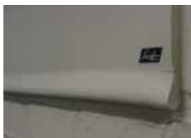
sydd fåll med stålrör 13 x 30 mm
